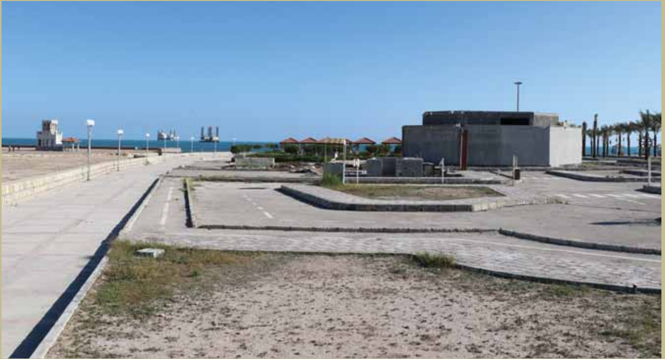
پلاتو در حال ساخت بندر لنگه در محوطه پارک دولت این شهر واقع شده و بناست توسط شهرداری به بهره‌برداری برسد که فعلا پروژه ساخت آن متوقف شده است.
